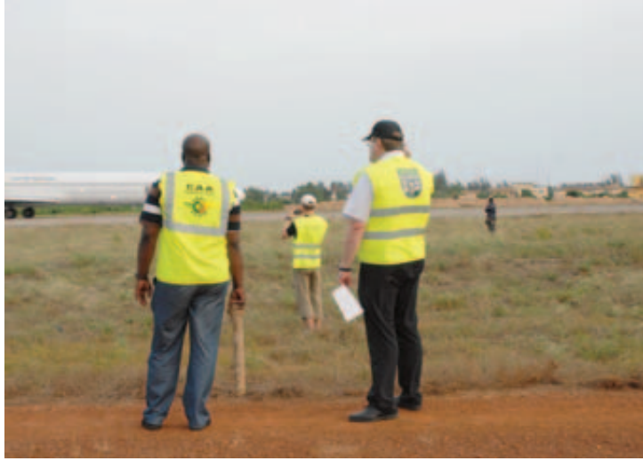
Visite de l'aéroport afin de déterminer l'emplacement des générateurs, en respectant les normes liées à la zone protégée de la piste. DR
