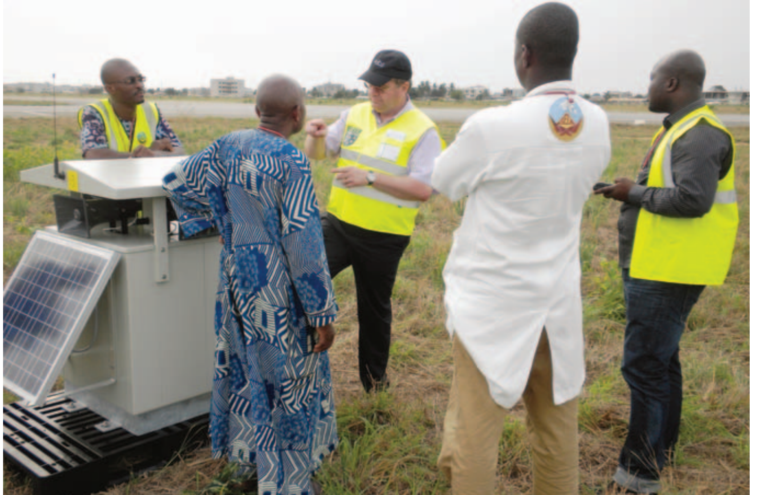
Stéphane Pillet (au centre), directeur de BTEE, explique le fonctionnement des générateurs de bruit aux responsables de l'aéroport de Cotonou et leur donne des recommandations pour limiter le risque lié à la présence de faune sur le site. DR
